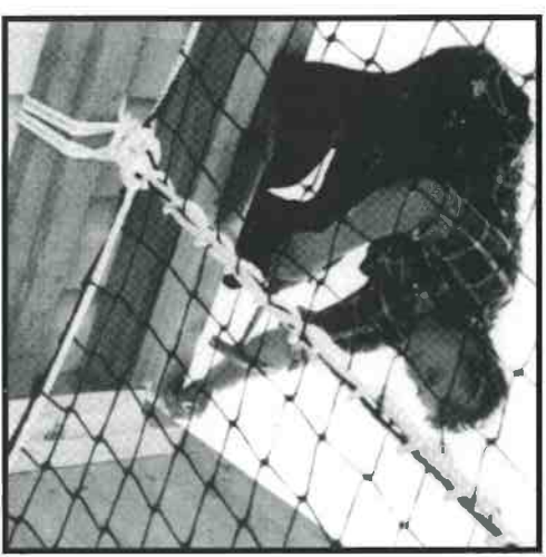
Fig. 12 Giuntura di reti con fune di accoppiamento.
